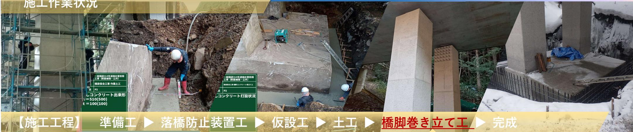
【施工工程】 準備工 ▶ 落橋防止装置工 ▶ 仮設工 ▶ 土工 ▶ **橋脚巻き立て工** ▶ 完成
